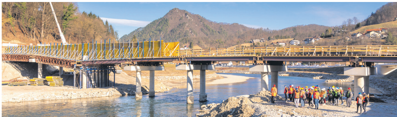
V istem tednu so vsi dijaki programa gradbeni tehnik, teh je v srednji šoli za gradbeništvo in varovanje okolja skupno v vseh letnikih 112, obiskali gradbišče gradnje mostu čez Savinjo v Laškem. Projekt so izdelali v podjetju Ponting.
