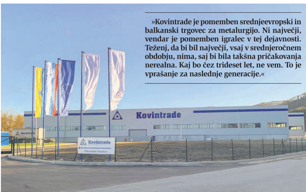
Z gradnjo še enega skladišča je Kovintrade v industrijski coni v Štorah postavil največji »steel center« v Sloveniji. (Foto: GIC gradnje)
