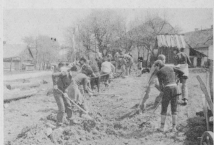
Doslej največja akcija mladih in tudi starejših občanov Zabljeka je izgraditev vaškega vodovodnega omrežja
