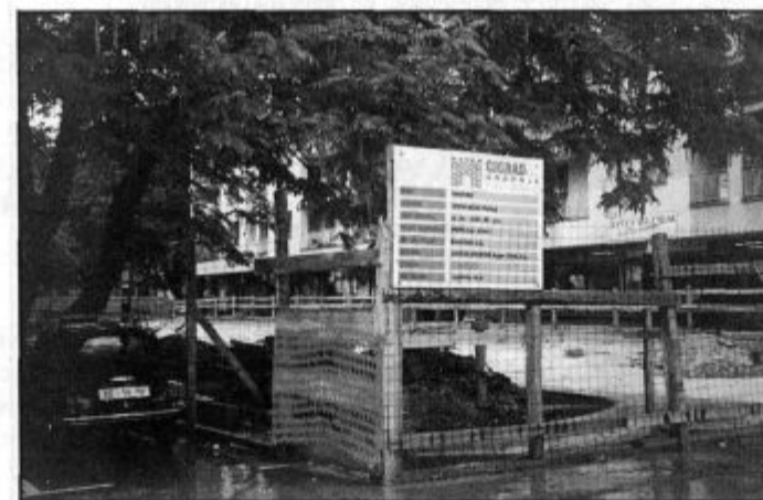
Preden so gradbinci pričeli z izgradnjo parkirišča, so morali odstraniti nekaj velikih dreves. Po končani izgradnji jih bodo nadomestili z novimi, po mnenju strokovnjakov tudi bolj primernimi.
