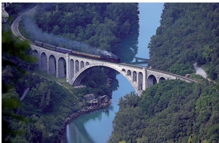
Muzejski vlak Solkan: Železniški most čez Sočo pri Solkanu. S 85 metrov dolgim lokom čez reko je bil to železniški most z najdaljšim kamnitim lokom na svetu.
