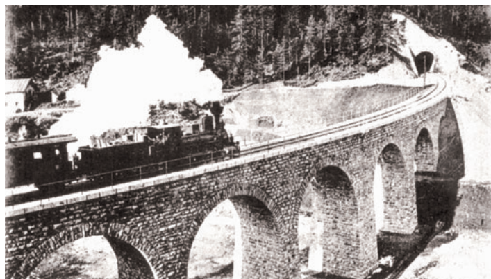
Gornji Dolič. Železniški viadukt pri Gornjem Doliču na mislinjski progi. Sredi leta 1944 so ga porušili partizani.
