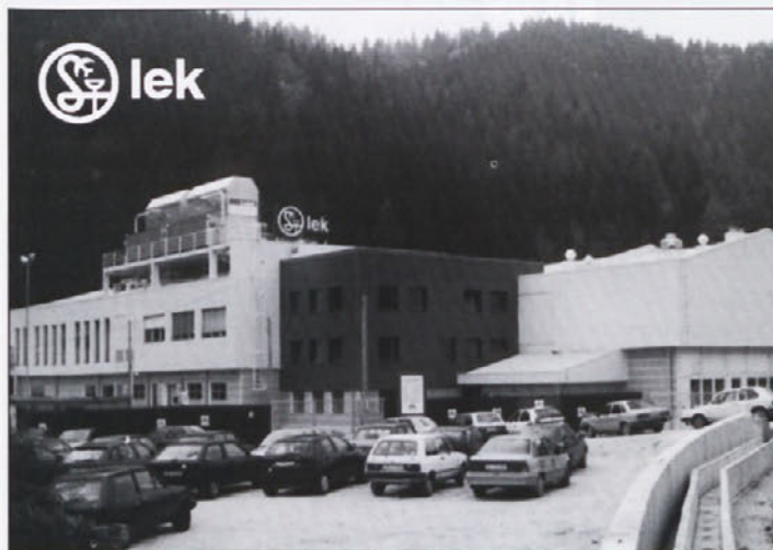
Prenovljen obrat Leka na Prevaljah
