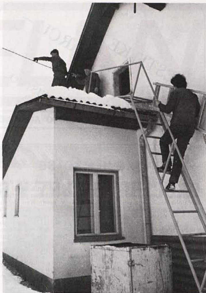
Montaža električnega voda za menzo
