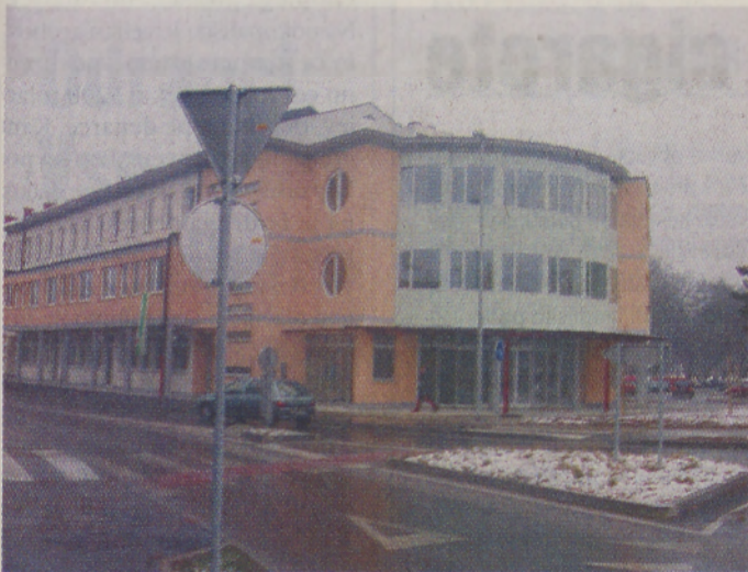
Investitor nove poslovno-stanovanjske stavbe v Ljutomeru je podjetje Segrap.
