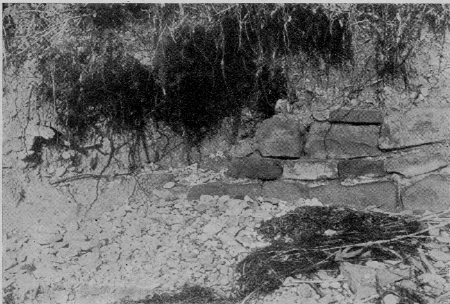
Sl. 6. 65 m profila. Struktura zidu 1 iz kompleksa zidov št. 5
