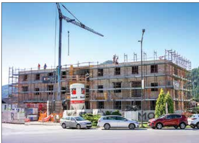
Delavci podjetja Remont spreminjajo objekt iz poslovnega v stanovanjski.
