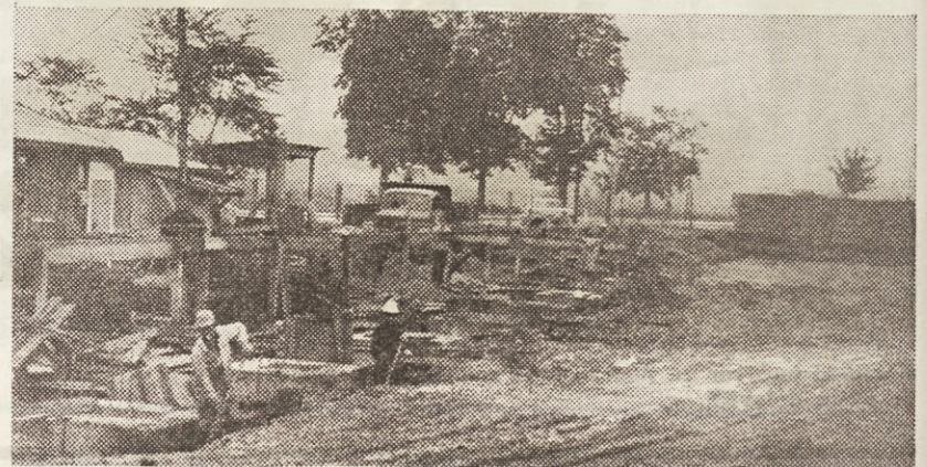
Vsi temelji za novo proizvodno halo v Topru so zgrajeni
