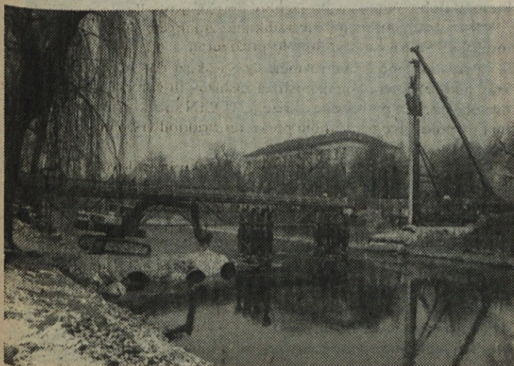
Stari Prulski leseni most v Ljubljani podirajo, na levem bregu Ljubljanice pa gradisovci že zabijajo betonske pilote dolge do 16 metrov, bo prihodnje leto dobil zamenjavo.
