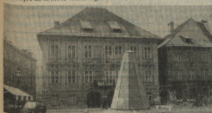
Na Stiškem dvorcu je bila prvič uporabljena horizontalna kemijska bariera s penetracijo silanov in silosanov.
