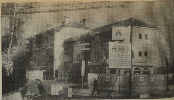
Poslovno stanovanjski blok v Žalcu je v zaključni fazi gradnje.
