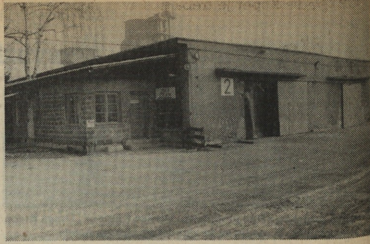
Proizvodni hali I. in II. sta dotrajani. Postaviti bo treba novo.
