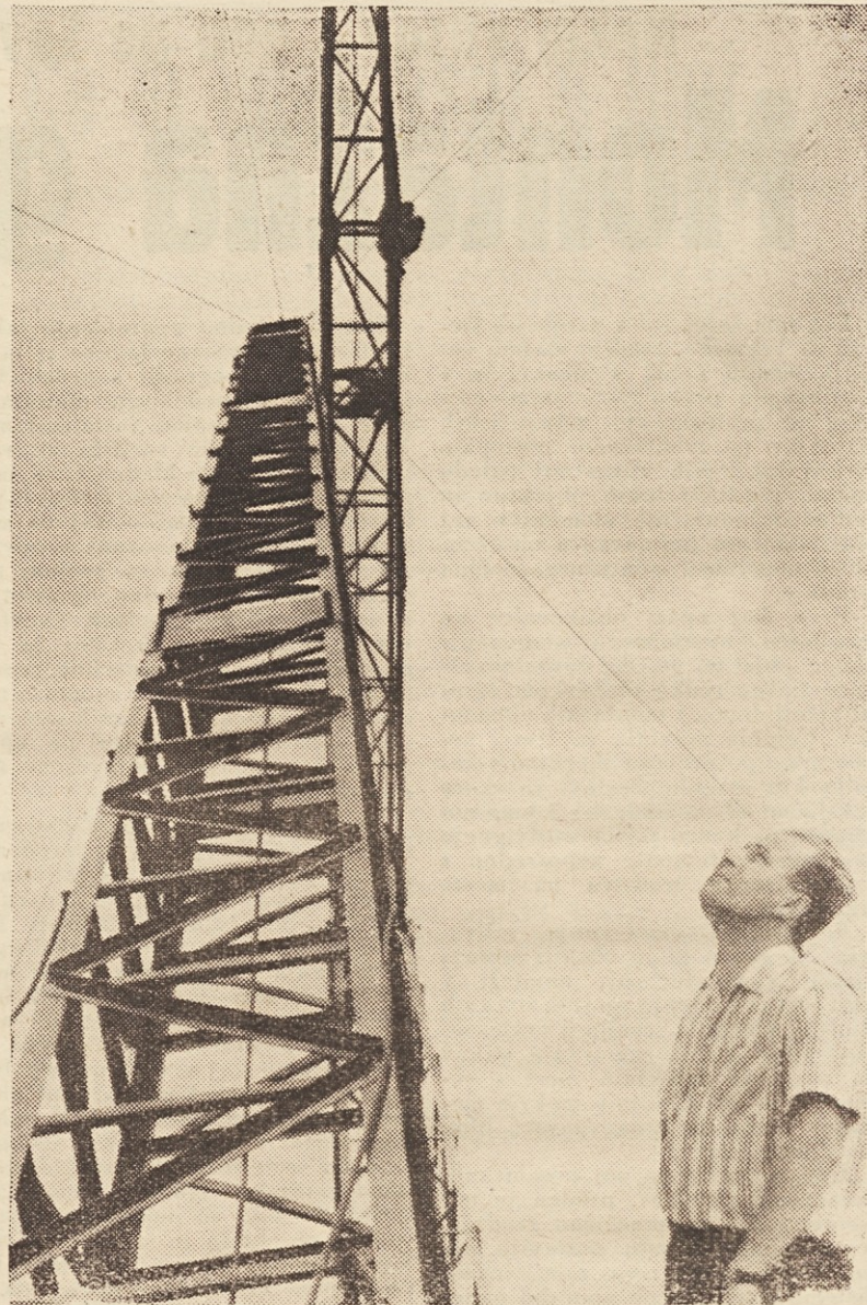
Sektorski vodja na GV Ljubljana tovariš Janez Kuštrin opazuje montažo žerjaya
