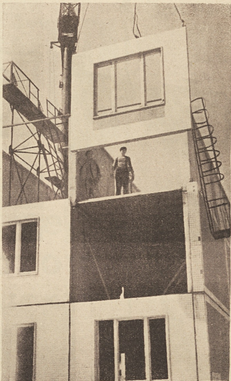
Montaža elementov na stavbi
