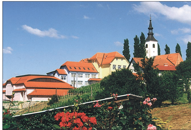
Destrniška osnovna šola je po porabi energije najbolj varčen objekt v državi
