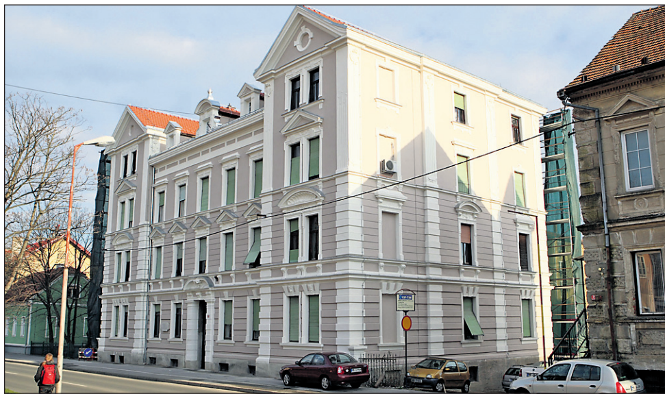
Podjetje za stanovanjske storitve je obnovilo meščansko vilo na Potrčevi 38, kulturni spomenik meščanske arhitekture.
