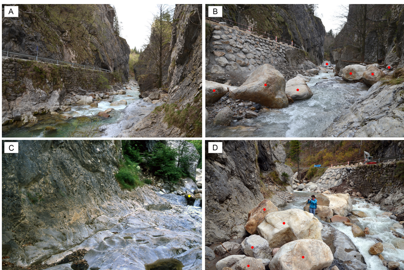
Sl. 7. Struga med cestnim predorom in malim predorom na desni strani struge (A in B – pogled s severa; C in D – pogled z juga). A) april 2014; B) november 2018; C) oktober 2008; D) november 2018.
