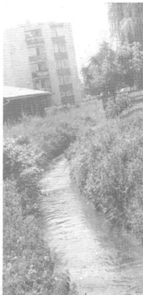
Delavci TOZD Hidrogradnje bodo očistili in obnovili strugo Gradašče
