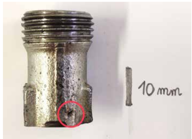
Slika 10 : Del kolena z vidno poškodbo, nastalo zaradi vodnega curka
