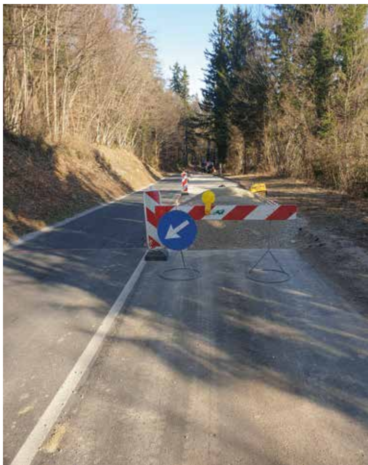
Dela potekajo ob delni zapori.
