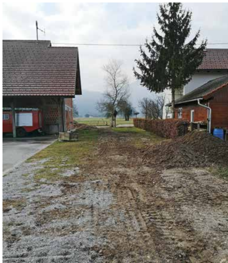
Nadaljevanje del na vodovodu v Kotu
