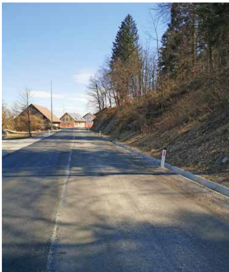
Nova asfaltna prevleka ceste v Podkraju
