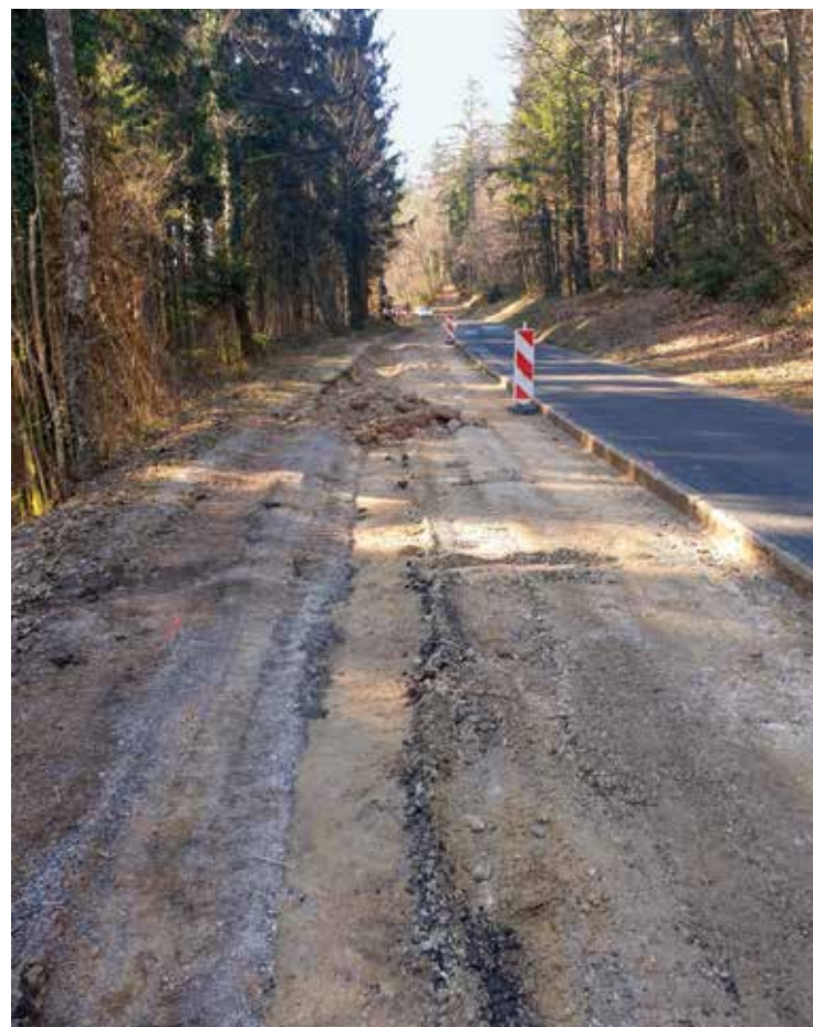
Saniralo se bo cestišče pri odseku za Dobravico.
