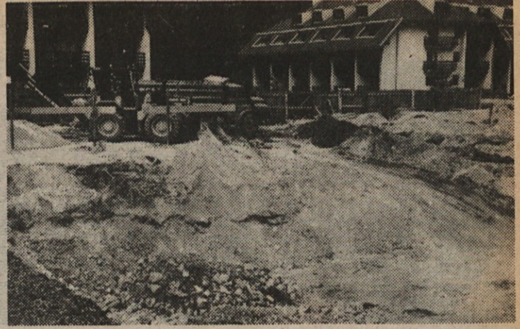
Izkop gradbene jame za blok s turističnimi stanovanji v Čičarah.
