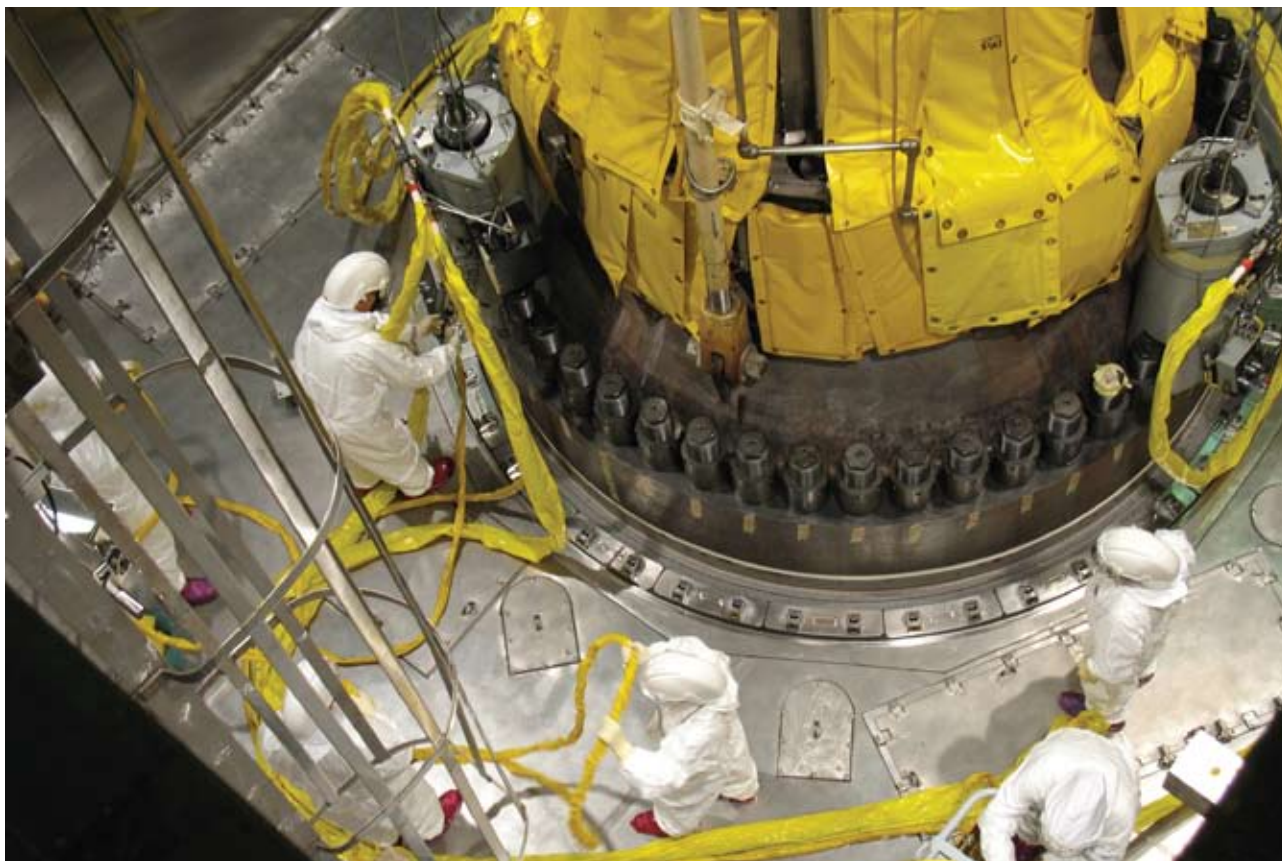
Remont v Nuklearni elektrarni Krško
