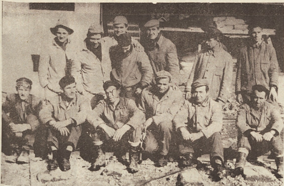
Zidarji in tesarji na objektu B-2 v Šiški
