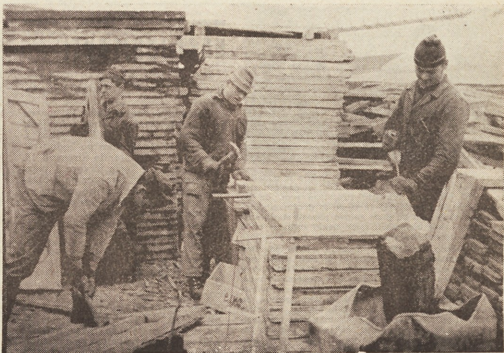
Pozimi je čas za popravilo opažnih plošč
