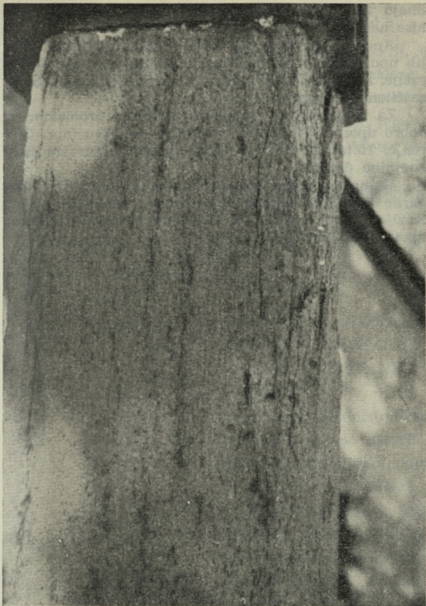
Sl. 4 Tuf Peračica — več sto let staro znamenje na prostem, ki je načeto od atmosferilij, predvsem zaradi zmrzovanja
