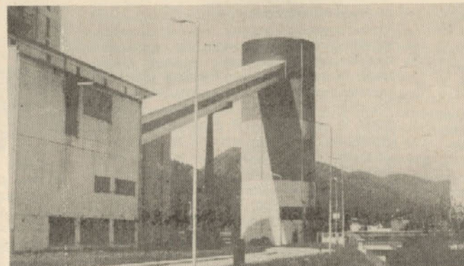
Bunker DIK Pesje 3, iz katerega poteka odvoz premoga za TEŠ, in del objekta 300, v katerem poteka klasiranje premoga, drobljenje premoga za TEŠ ter nalaganje premoga na vagonce in kamione
