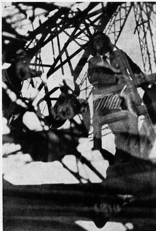
Pod Eifflovim stolpom v Parizu
