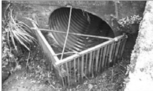
Očiščena (zgoraj) in zamašena (spodaj) odtočna cev
