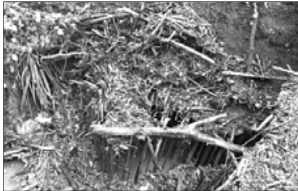
Očiščena (zgoraj) in zamašena (spodaj) odtočna cev
