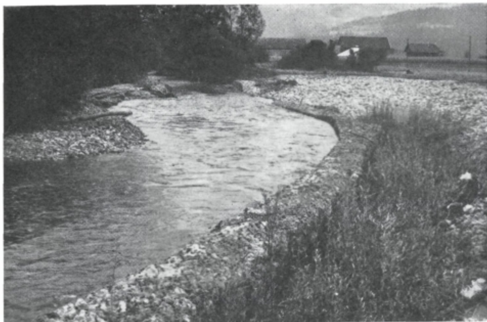
Sl. 10. Poplava ob Dreti severozahodno od Delc junija 1974 je spodkopala in zasula del kašte, narejene po oktobrski poplavi 1973
