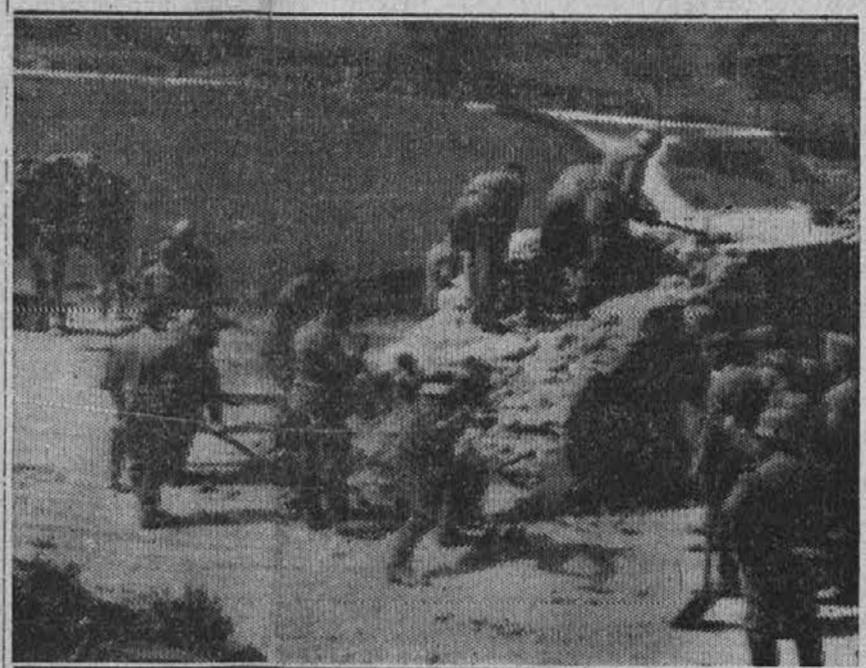
Na sliki vidimo zid, katerega so postavili Belgijci preko ceste, da bi zaustavili prodiranje nemških tankov. Nemci so se spravili ročno s krampji nad zapreko ter jo podrli.
