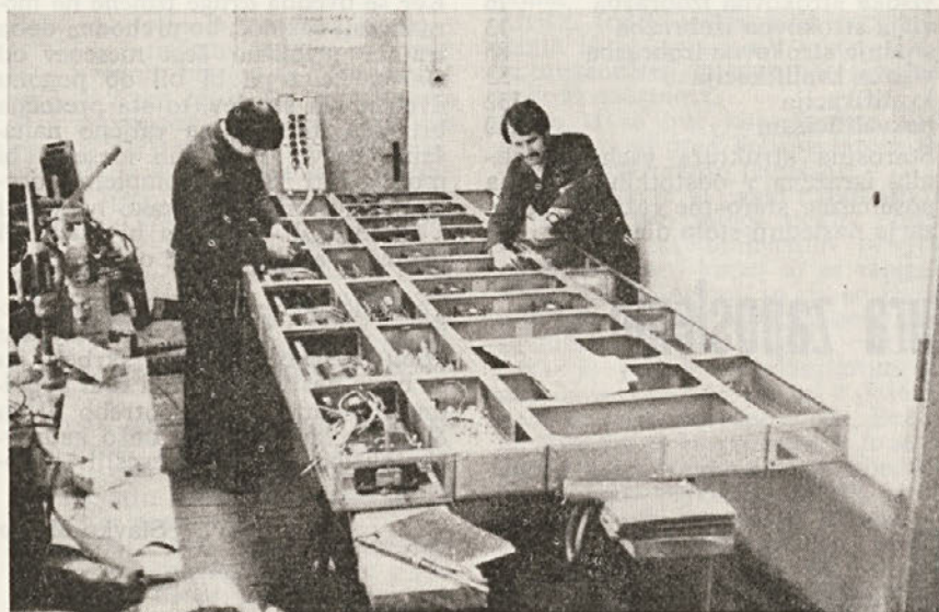
Razdelilna omara za komplet elektroinstalacij v TPP-ju
