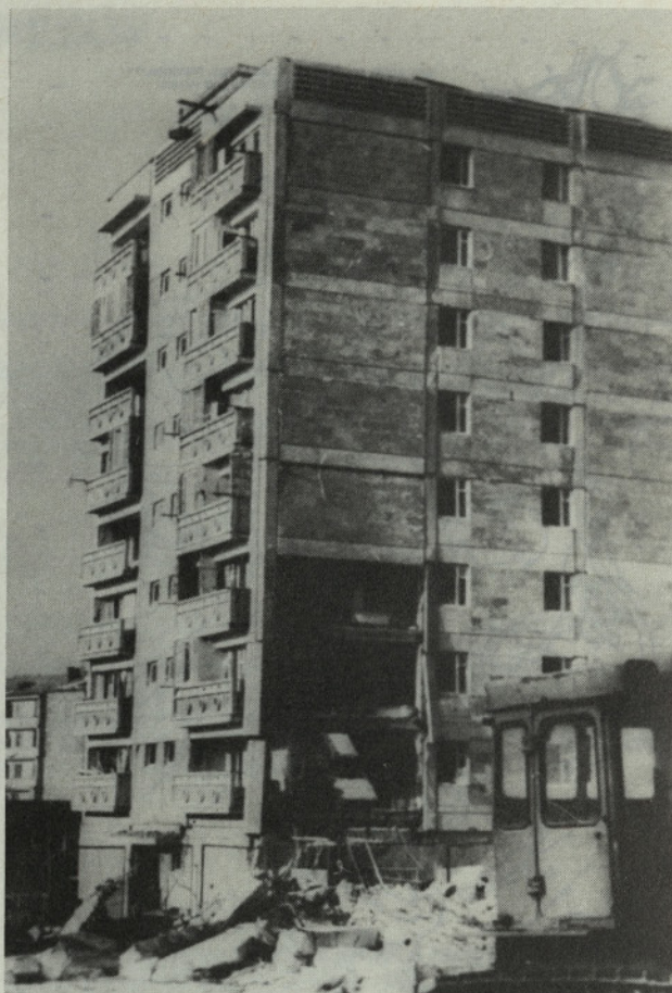
Slika 4. Skeletnopanelna montažna stanovanjska zgradba v Leninakanu (ena izmed redkih, ki se ni porušila)
