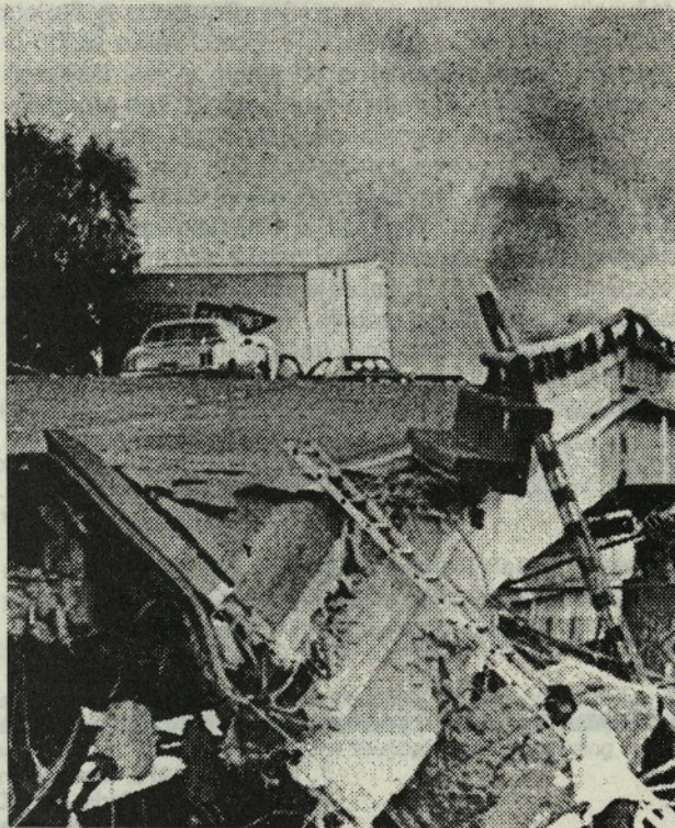
Slika 5. Delno porušeni viadukt v San Franciscu
