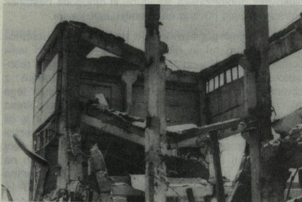
Slika 3. Porušena montažna konstrukcija v Spitaku
