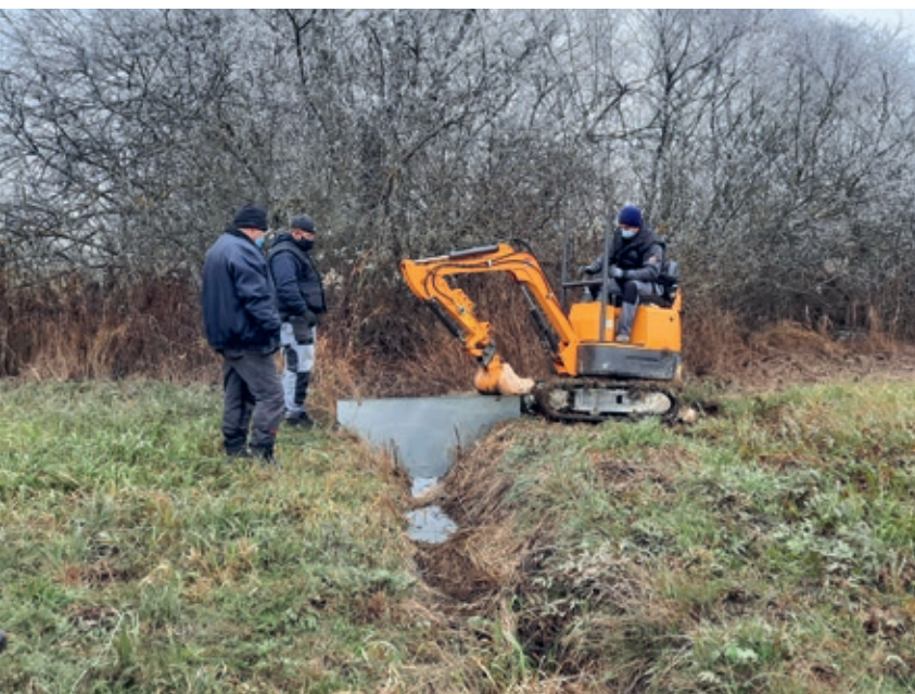
Nameščanje mikrozapornice
