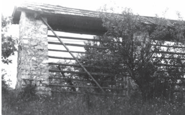
Uršičev kozolec z zidanimi oporniki – babcami na Dobravici
