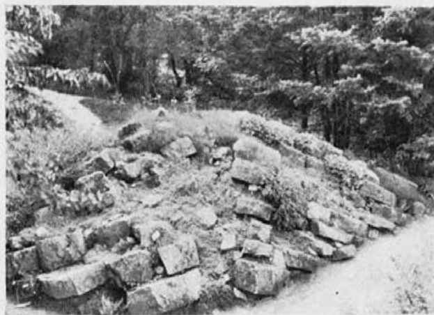
Apnenčevi kvadri so položeni tako, da ustrezajo konfiguraciji terena
