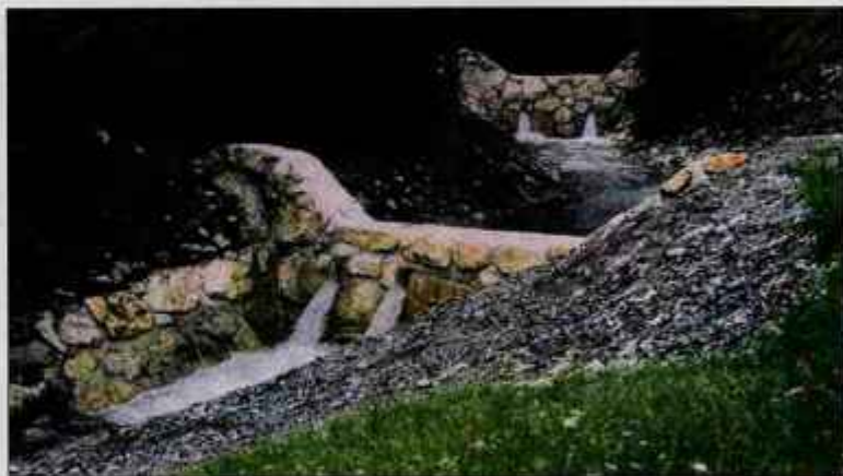
Na vodotokih v Železnikih so zgradili številne obrežne zidove in prek 40 zaplavnih pregrad, kar pa še ne zagotavlja zadostne poplavne varnosti.
