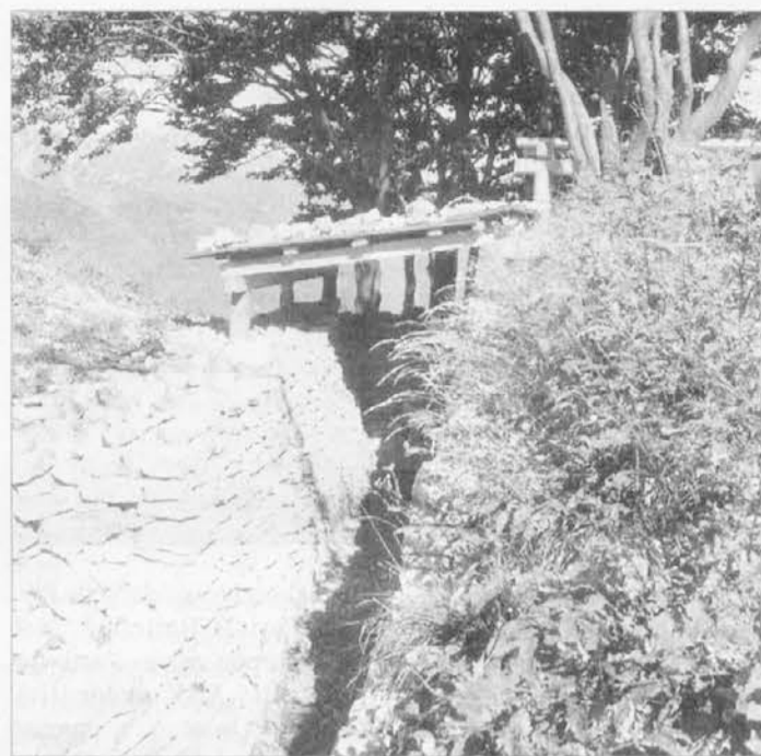
Pogled na del obnovljenih jarkov na Kolovratu
