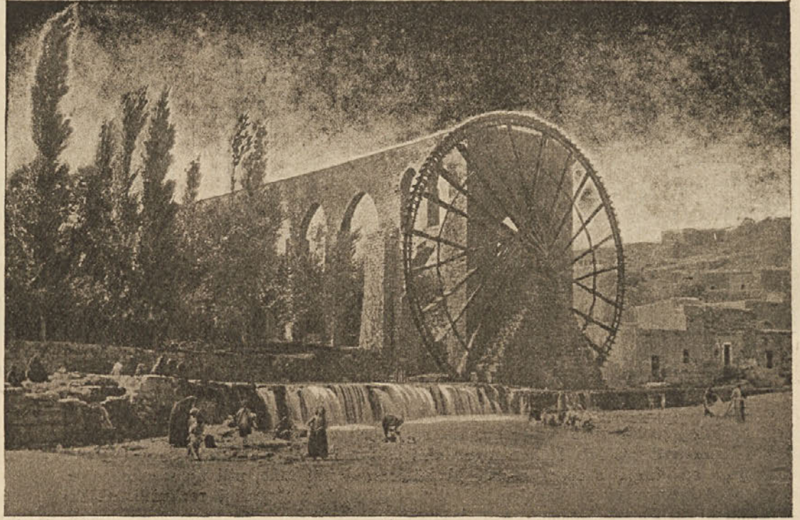
Največje vodno kolo na svetu: Vodno kolo v sirskega mesta Hama, ki proizvaja gonilno moč za stroje v mestni vodarni. Zadaj se vidijo še razvaline starega mesta.
