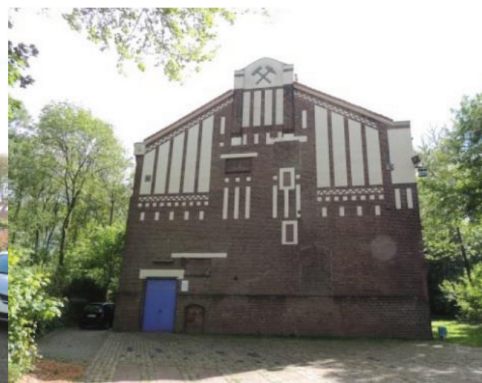
V naselju odkrijem rudniški objekt z opečnato fasado. Skrbno načrtovana gradnja iz skromnih gradnikov je omogočila lepe vzorce in teksture.
