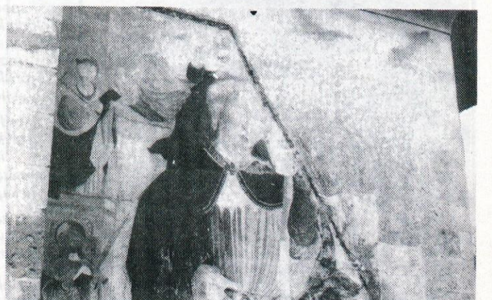
Razmeroma dobro ohranjen detail freske sv. Krištofa na zunanji steni nad zakristijo cerkve sv. Marjete na Gradišču. Ohranjen je samo tisti del freske, ki je bil na podstrehi zakristije, drugi del freske, ki je bil izpostavljen vremenskim razmeram, je uničen. Ko je vihar v letu 1992 ostreje vrgel na tla, je ostala freska nezavarošana. Ostreje na zakristiji so znižali in jo pokrili z bakreno pločvino
