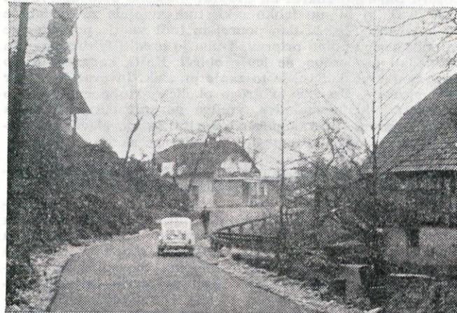
Proti Vačam so položeni prvi metri asfalta.
