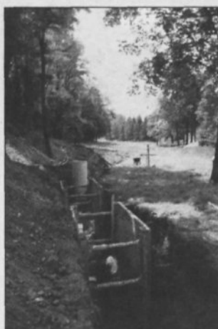
Kanal S1 V izgradnji
