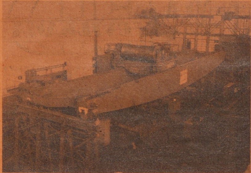
Delavniška montaža kovaškega žerjava za železarno
