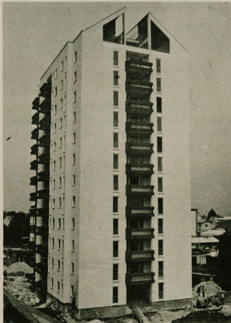
V središču Domžal lahko vidimo „nebotičnik“, ki ga je zgradilo Gradbeno industrijsko podjetje OBNOVA in v katerem bo 60 stanovanj
