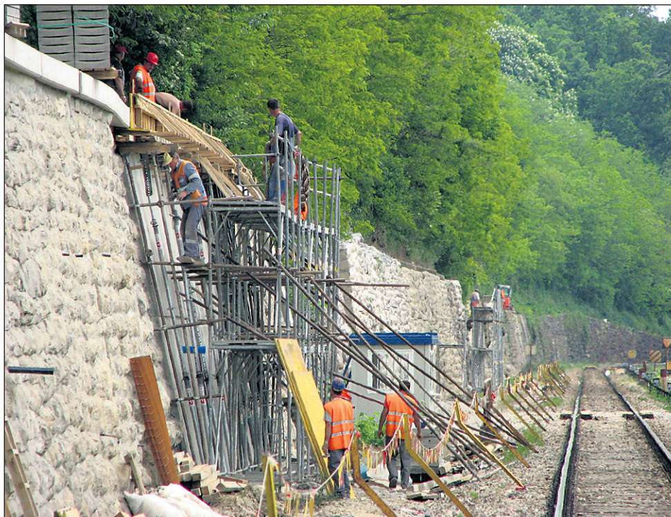
Foto: vki Obnovilo se bo tudi 1600 metrov podpornih zidov med Veliko Nedeljo in Ormožem.
