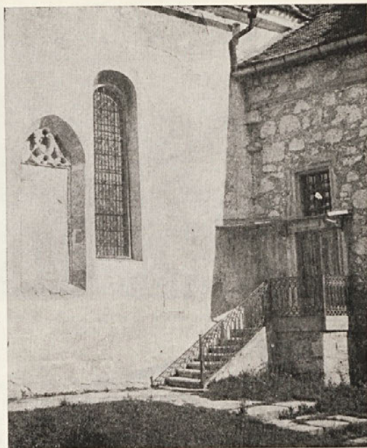
Sl. 5. Leta 1937 odkrito gotsko okno v južnem zidu cerkvene ladje (foto: Tone Mlakar)
