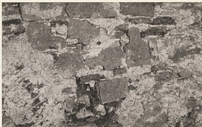
Sl. 7: Deli obočnih reber prvotnega »kratkega kora«, ki so bili uporabljeni kot gradivo v zidu nad slavalokom v obsegu podstrešja (foto: Franc Kučej).
