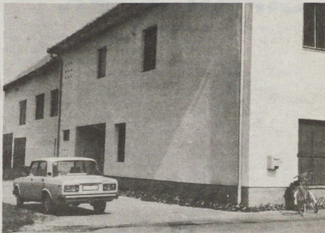
Vaško-gasilski dom v Trnju, h kateremu so zgradili prizidek.
