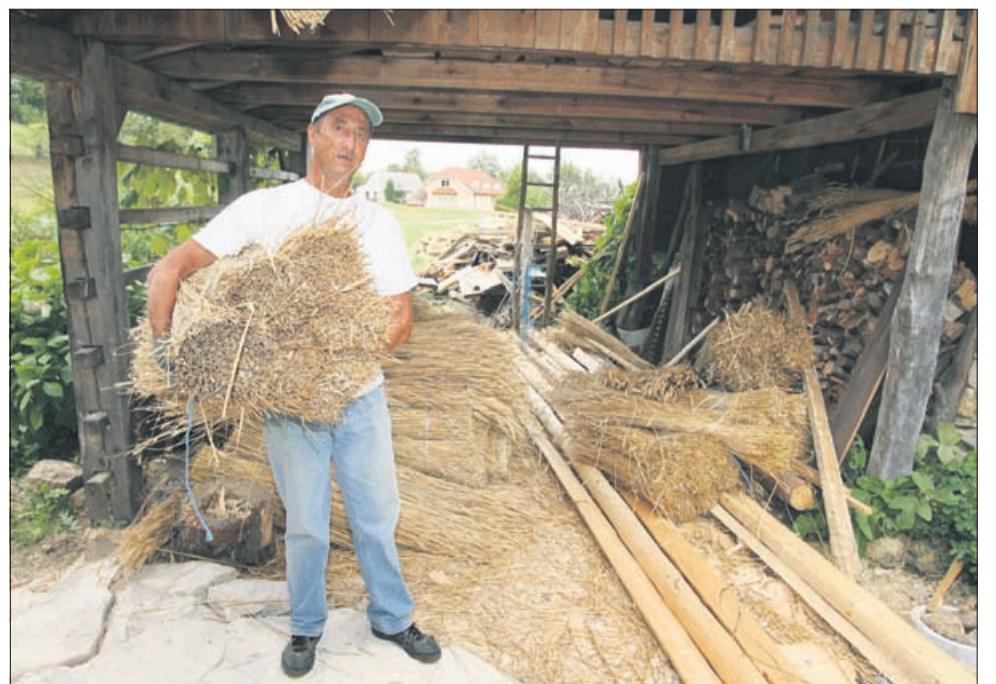
Golnarji na leto požanjejo 12 hektarov žita, v glavnem rži, ki ima za kritino najboljšo slamo. Primerna bi bila tudi pirina slama, a jo imajo žal rade tudi miši, pa se zato zanjo redkeje odločajo. Krovca na strehi brez pomočnika na tleh ne naredita prav dosti.
