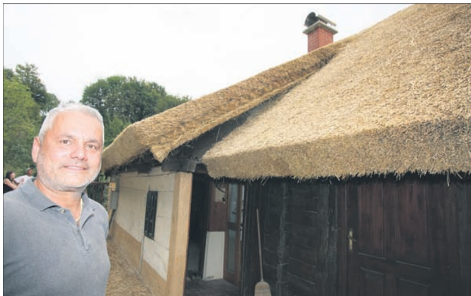
Lastnik domačije Aleš Brus pred hišico, pokrito s slamo, ki jo položijo od 25 do 30 centimetrov debelo. Prvih nekaj let je še trdovratna, potem pa jo vremenski vplivi pobirajo približno centimeter na delo. A če je delo dobro opravljeno, ste s tako kritino 30 let varno pod streho.
