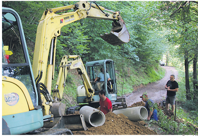
Ekipa, ki je v cesto vgrajevala odtočne betonske kanale.
