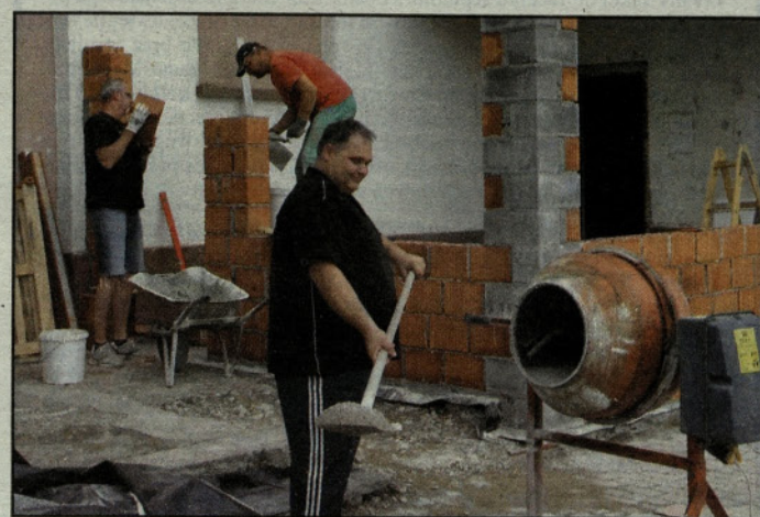
Obnova v teh dneh
