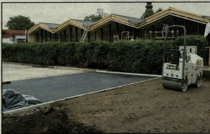
Gradnja prizidka vrtca poteka po planu
