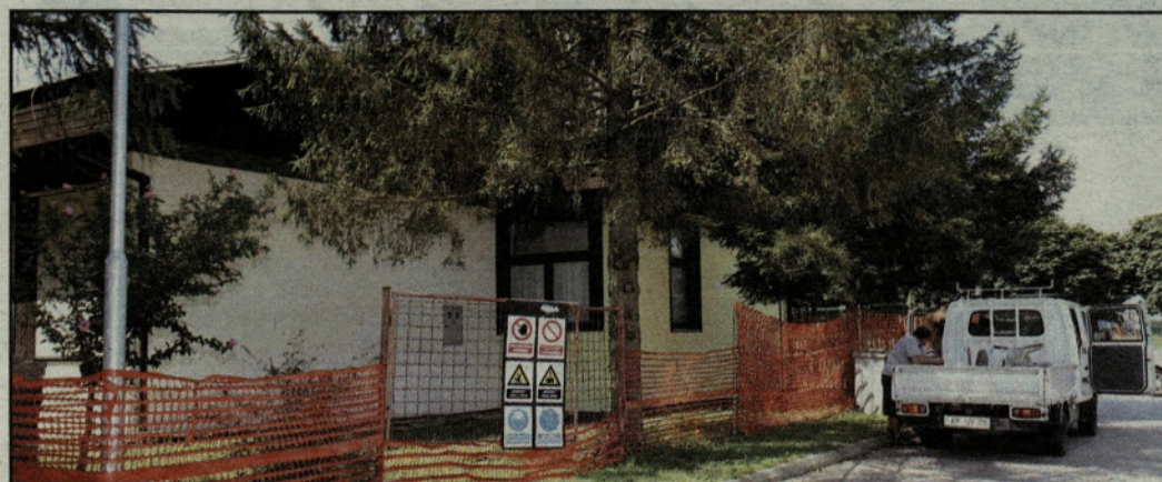
Obnova v Levcu vključuje med drugim sanacijo ovojne stavbe
