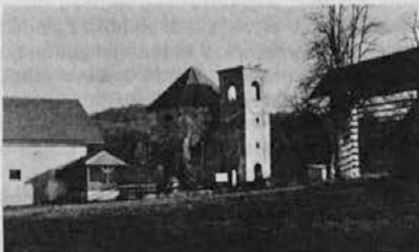
Pogled na kapelico med prenovo
