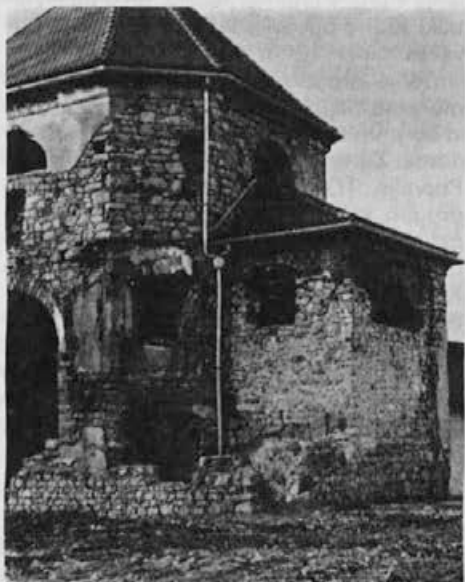
Nova streha, žlebovi in ojačana južna stena so bila prva najnujnejša dela, da se objekt ne bi podrł.
