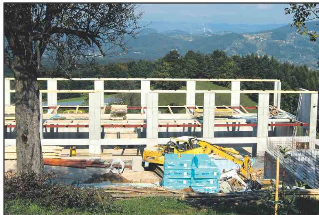
Gradbišče tu, gradbišče tam - hladilnica, novi hlevi, prostori za predelavo sadja, zelenjave, mesa ...
