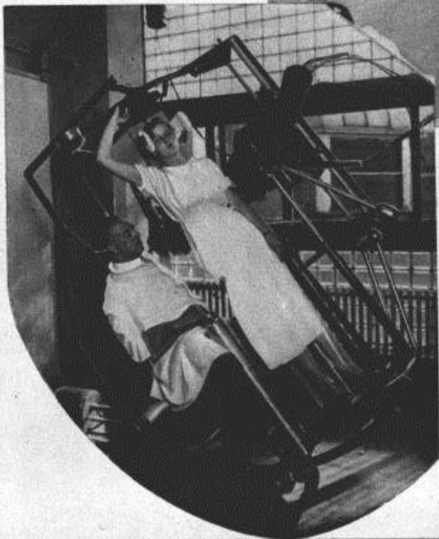
Mit dem Fahrstuhl die Feuerleiter hinunter. Die Fahrt abwärts (rechts) geht ganz ruhig aus; und das Ausstoppen am Schluß (oben)? — Gedacht ist dieser Stuhl für die Rettung von Kranken, die so schnell und gefahrlos aus brennenden Häusern geborgen werden können D.P.Z., Atlantic
