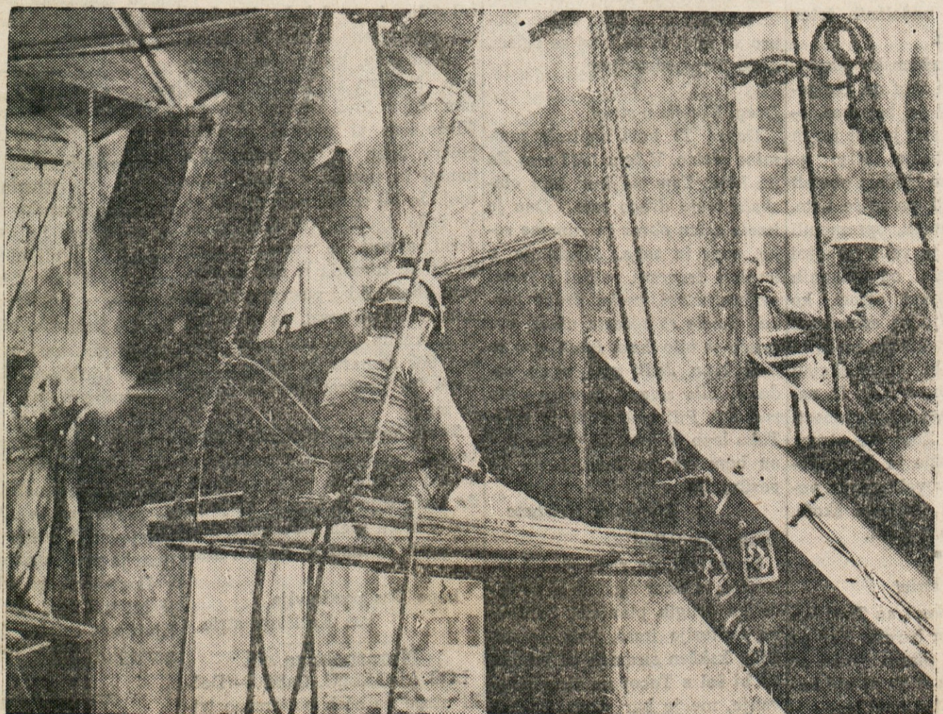
VSE ZVARJENO — Jekleno ogrodje 110-nadstropne zgradbe World Trade Centra v New Yorku je zvarjeno. Na sliki vidimo na levi spredaj delavca pri varjenju, na desni pa nadzornika, ki s posebno nadzvočno napravo išče morebitne napake v zvarjenih delih.
